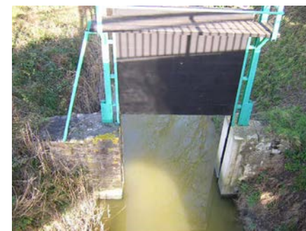
Ouvrages hydrauliques dans le marais de Dol
